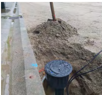
Einbringen der frischen Rasentragschicht auf der Rasenheizung und neues Laserplanum
