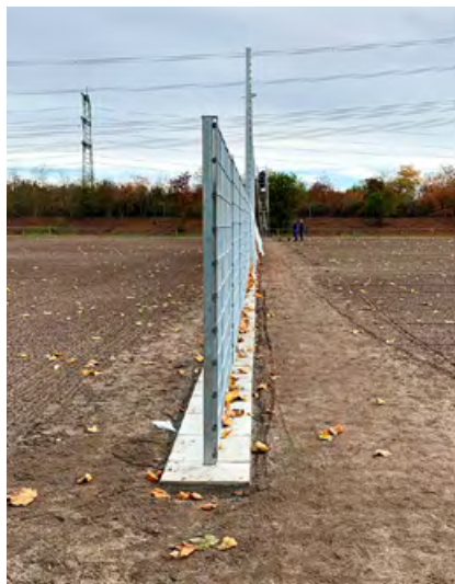
Mittig unter der Zaunanlage verlegte Betonplatten sorgen für eine Mähkante zu beiden Spielflächen.
