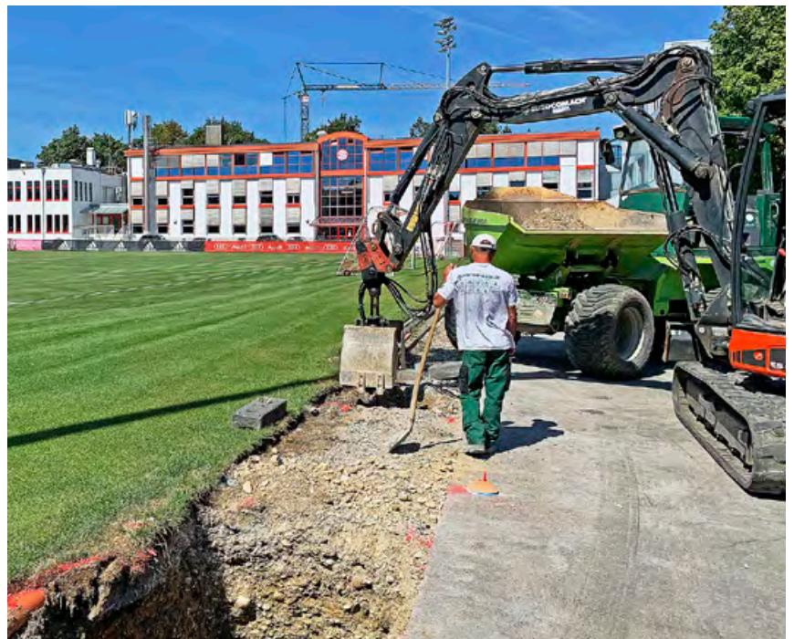
Einbau der 68 neuen Punktfundamente
