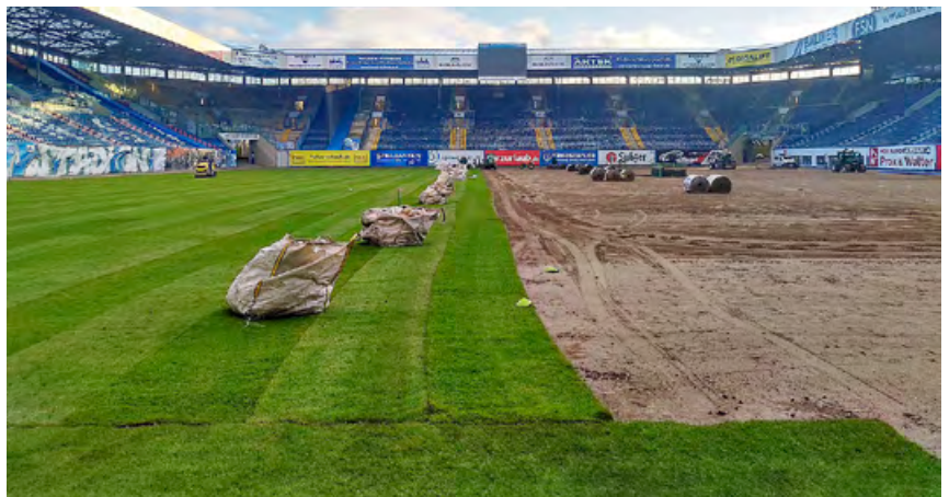
Verlegung des Rollrasens als frisch geschälte, ca. 4 – 5 cm starke Dicksode
