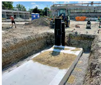
Einbau der Sickerrigolen im Baugrund
