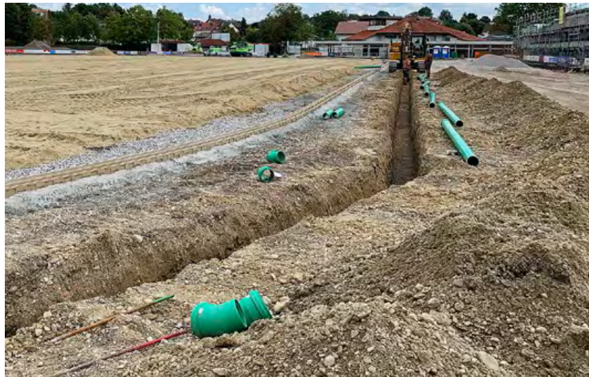
Einbau der Entwässerungsrinne sowie der Drainagekanäle unter der neuen Laufbahn
