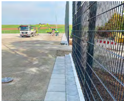
Geländemodellierung mit Mauerscheiben vor der Zaunanlage
