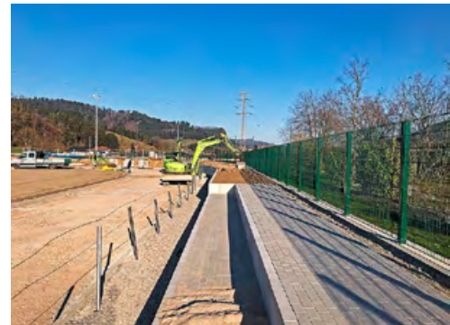
Einbau der Sitzstufen am Seitenaus und neue Pflanzflächen
