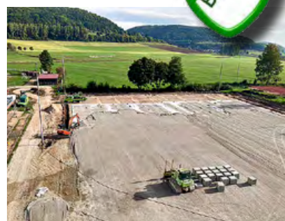
Verlegung von Geogitter für höhere Bodenstabilität
