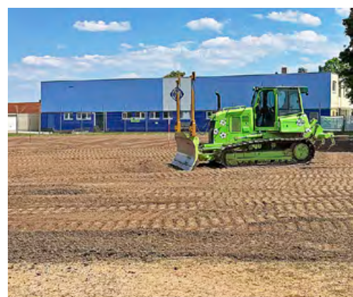
Aufbereitung der Spielfläche für die Faustballer und Vorbereitung zum Einbau der neuen Versenregner
