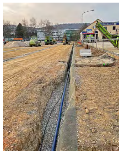
Einbau der Maulwurf-Gittersperre
