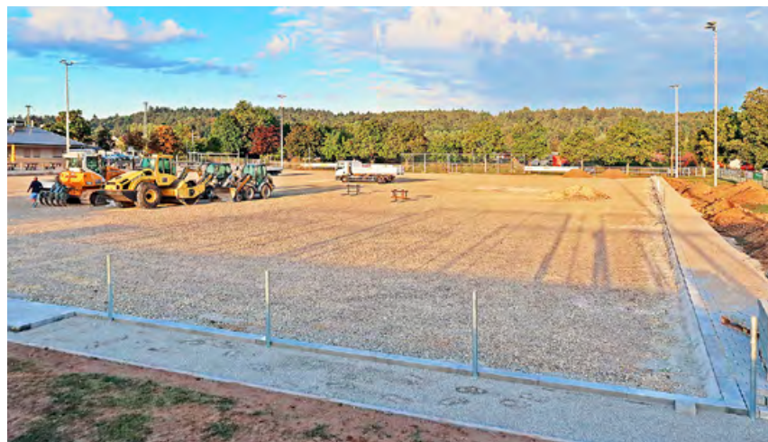
Schotterplanum, Barrierenfundamente und umlaufende Wege
