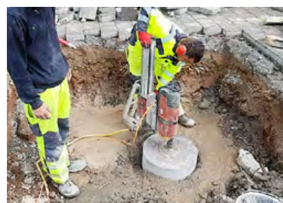
Ertüchtigung der Flutlichtfundamente mit riesigen Diamant-Bohrkronen
