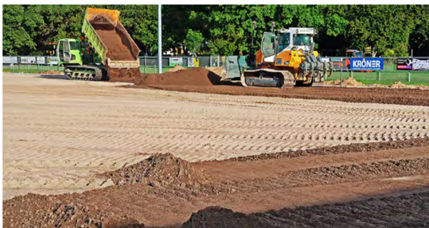
Einbau der neuen Rasentragschicht
