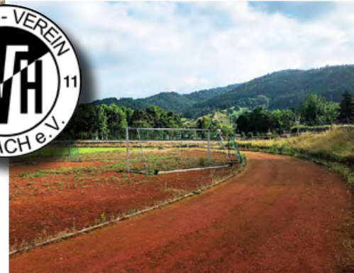
Zustand vor der Sanierung ...
