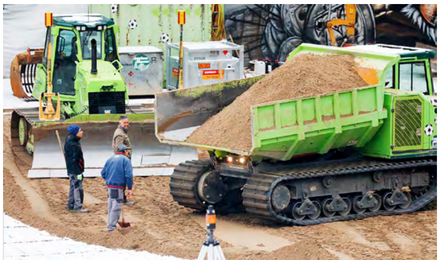
Einbringen der frischen Rasentragschicht auf der Rasenheizung und neues Laserplanum
