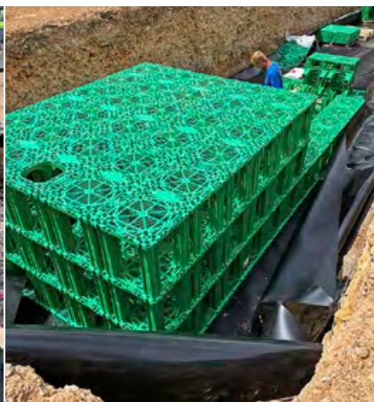
Einbau der Rigole in den felsigen Untergrund (Installation in Modulbauweise)
