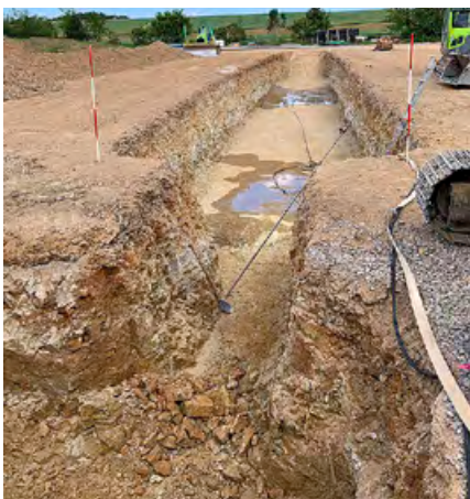
Einbau der Rigole in den felsigen Untergrund (Installation in Modulbauweise)
