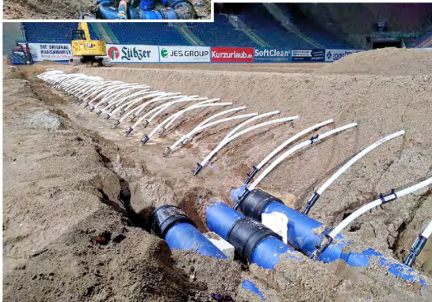
Spielfeldaufbau mit 28 km Heizleitungen und Anschluss an den Tichelmann-Verteiler (kleines Bild)
